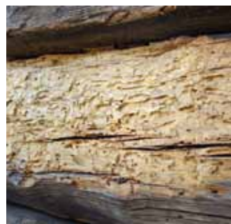
Specjalne rusztowanie podtrzymuje strop i dach remontowanego prezbiterium POWIĘŻ: Jedna z belek w prezbiterium kościoła zniszczona przez korniki
