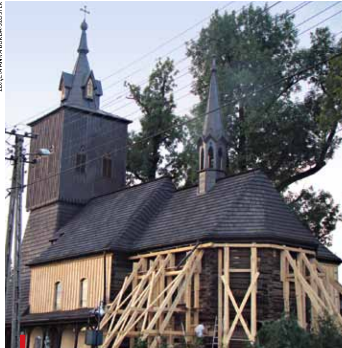
Specjalne rusztowanie podtrzymuje strop i dach remontowanego prezbiterium POWIĘŻ: Jedna z belek w prezbiterium kościoła zniszczona przez korniki
