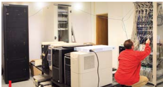
Nowoczesna serwerownia daje możliwość zastosowania najnowszych technologii
