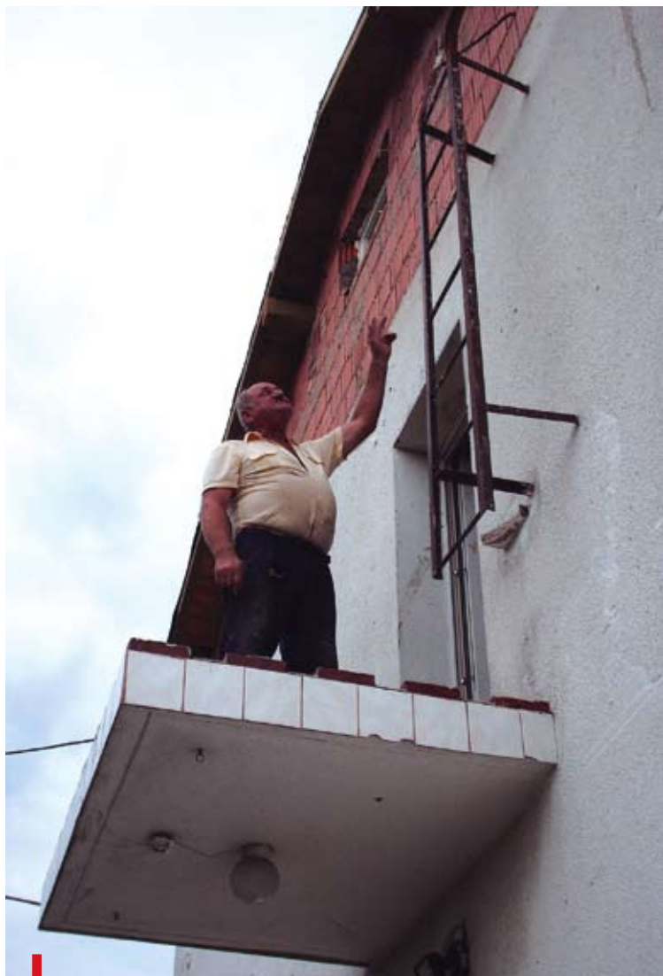
– Nowe cegły wskazują na miejsce, z którego trąba zerwało dach – mówi Jerzy Serafin
