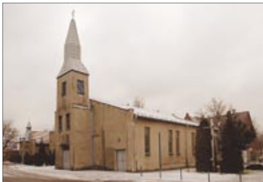
Kościół parafialny przebudowano z budynku dawnej szkoły
