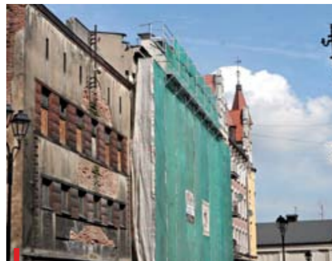
Dawne kino Capitol pokryte siatką rusztowań. Prace prowadzone są jednak wewnątrz budynku
