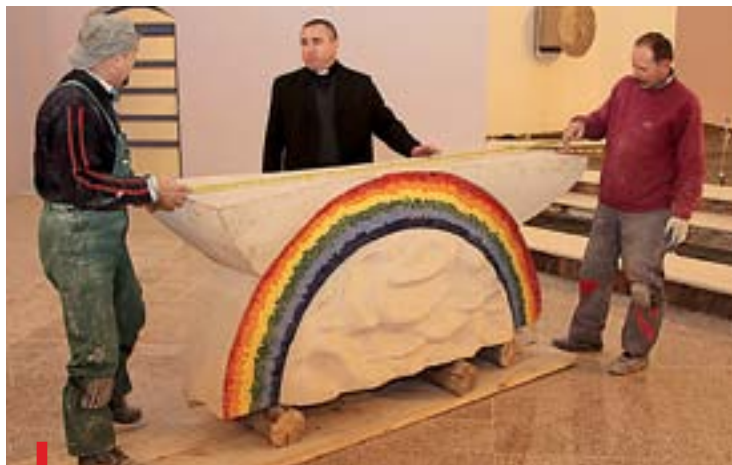
Na ostatniej prostej – ks. Alfred Tatarzyn z robotnikami pracującymi przy wykończeniu prezbiterium kościoła
